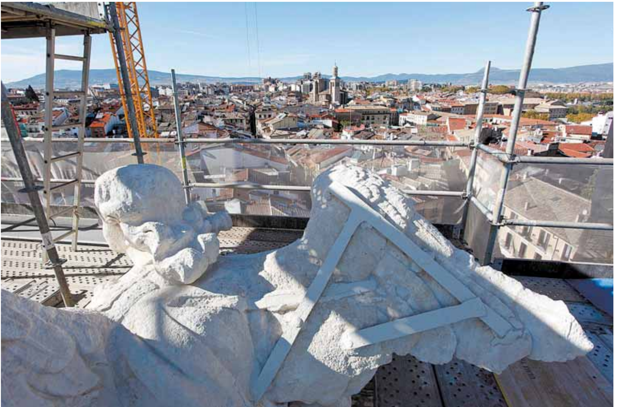
Uno de los dos ángeles de la fachada tenía un ala rota en dos partes, pero las piezas se conservaban, de modo que se han recolocado con ayuda de un cabestrillo metálico.
