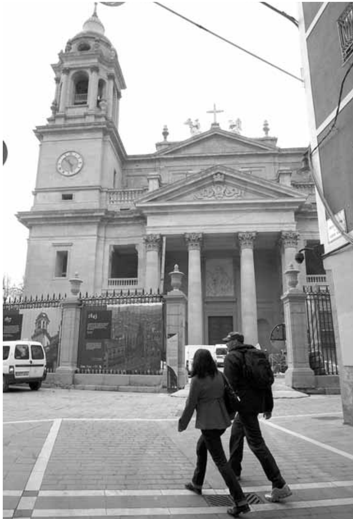
La fachada de la catedral, libre de los andamios que la han cubierto durante un año.
